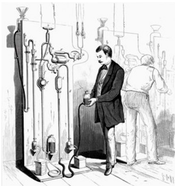
Uomini al lavoro nella fabbricazione di lampadine a bulbo di Edison, illustrazione di Scientific American, 1880
