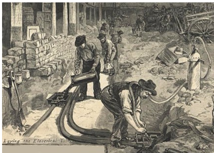
La posa dei cavi elettrici nei relativi tubi, New York
